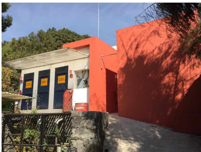
Figura 3. Almacén temporal de los residuos peligrosos
